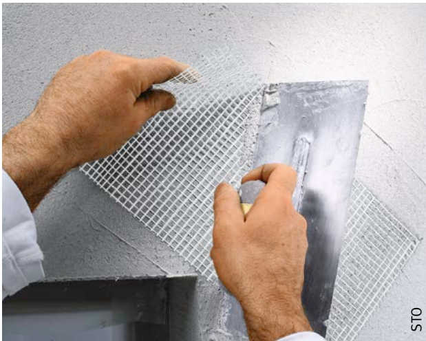
Afb. 127 Plaatsing van een strook wapeningsweefsel in de hoek van een opening.
