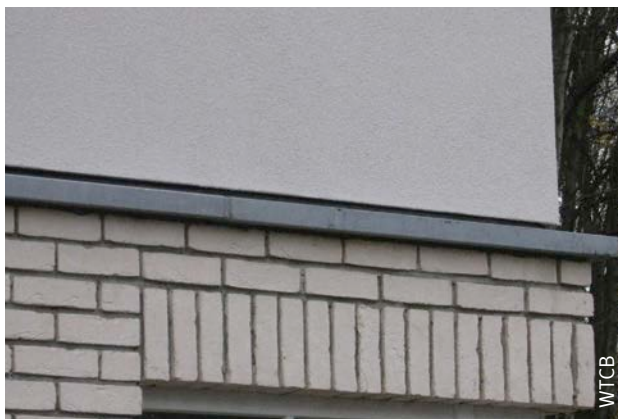
Afb. 82 Aansluiting van een ETICS met een spouwmuur.
