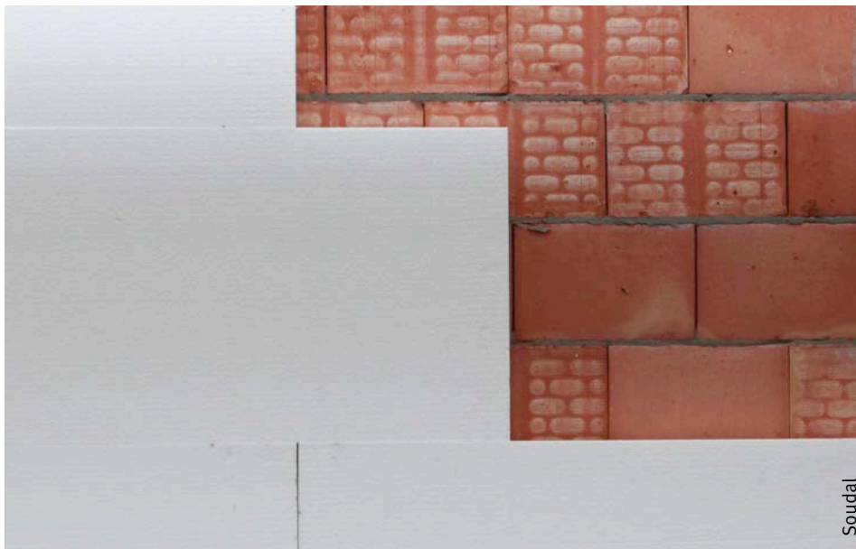
Afb. 99 Plaatsing die afgestemd is op de verspringende verticale voegen van platen met aangepaste dimensionale toleranties.
