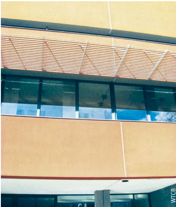
Afb. 87 Bewegingsvoegen aan het oppervlak van een ETICS.
