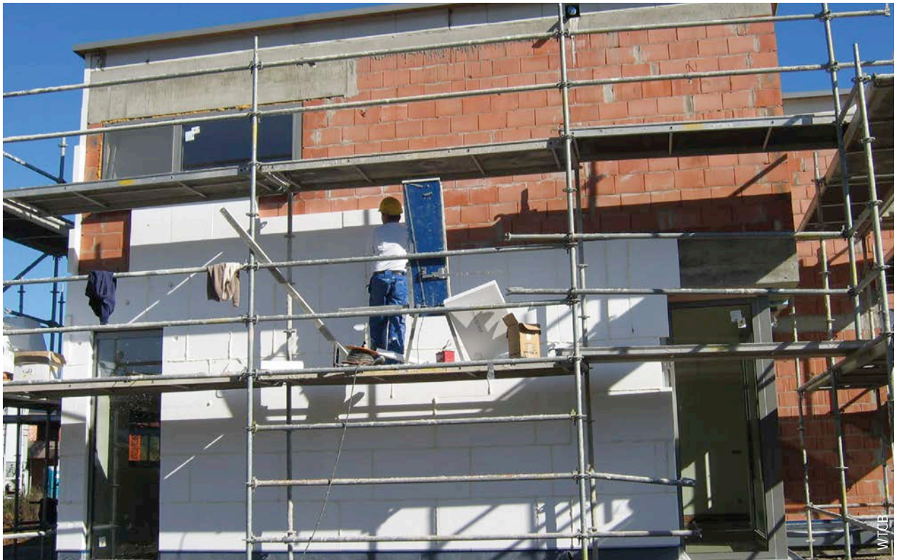
Afb. 13 Plaatsing van een isolatie op een buitengevel.
