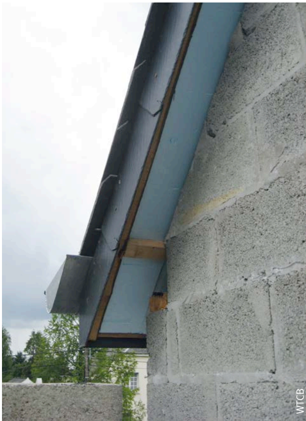
Afb. 74 Aansluiting met de dakzijrand van een hellend dak (zicht op de tussengevoegde isolatie vóór de gevelwerken).
