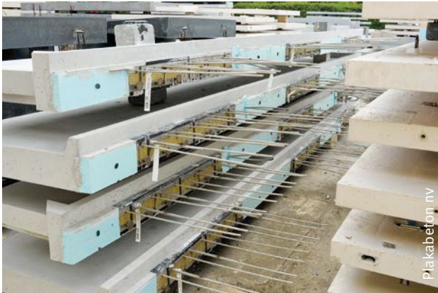
Afb. 79 Geprefabriceerde balkons met een geïntegreerde thermische onderbreking.
