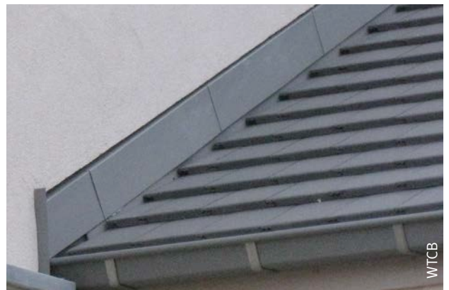
B. Aanzicht na de plaatsing van de dakbedekking
