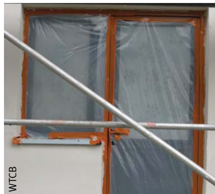
Afb. 93 Bescherming van een raam en een deur.
