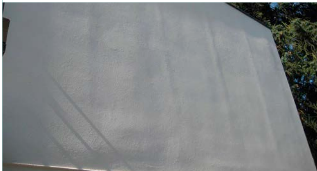
Het aftekenen van de overlappings van het wapeningsweefsel.
