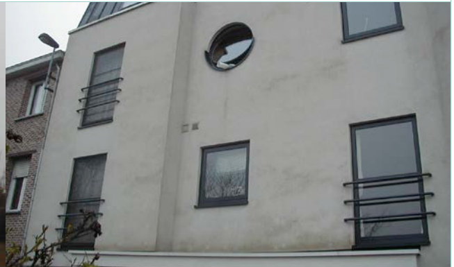
Veroudering van de bepleistering in een stedelijke omgeving.
