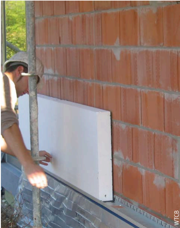
Afb. 100 Plaatsing van de eerste isolatieplaat in het sokkelprofiel.
