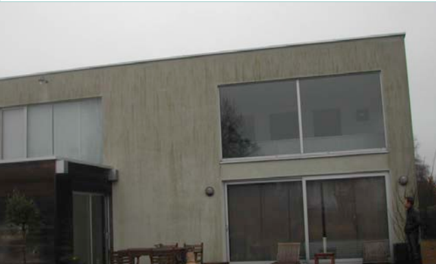
Vroegtijdige veroudering van de bepleistering.
