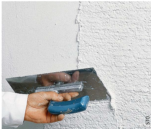
Afb. 135 Aanbrengen van een afwerkpleister (uitsmeren).
