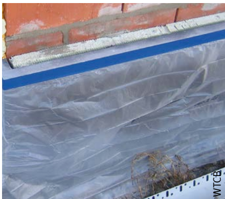
Afb. 92 Bescherming van een plint.
