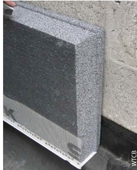
Afb. 64 Aansluiting aan de aanzet van platte daken.
