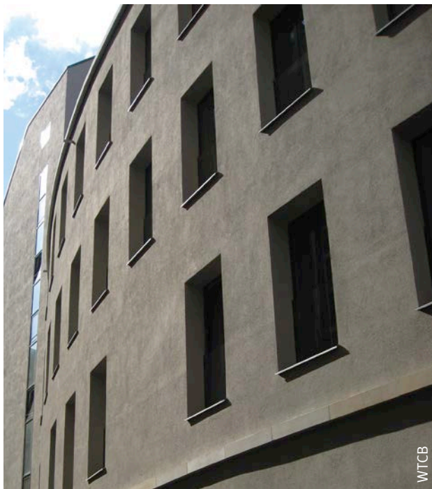
Afb. 51 Plaatsing in neg (aanbevolen).
