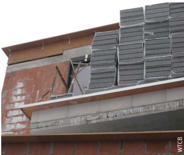
Afb. 66 Aansluiting met de dakranden van platte daken (vóór de ETICS-werkzaamheden).
