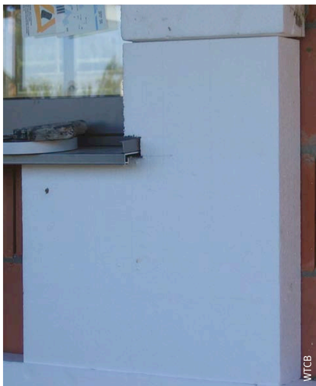
Afb. 109 Plaatsing van een vooraf versneden plaat uit één stuk in de hoek van een dagopening.
