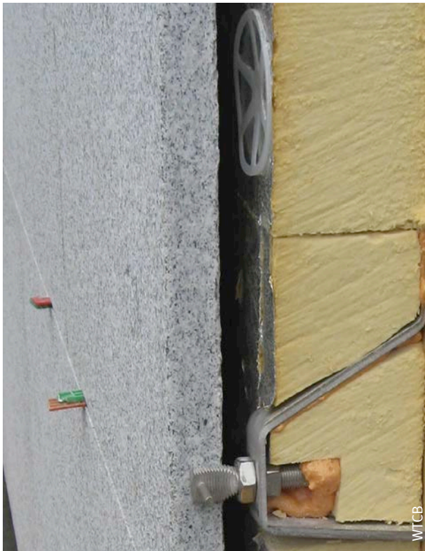
Afb. 45 Verankerde natuursteenplaat en sokkelisolatie voor de afwerking van de ondermuur.
