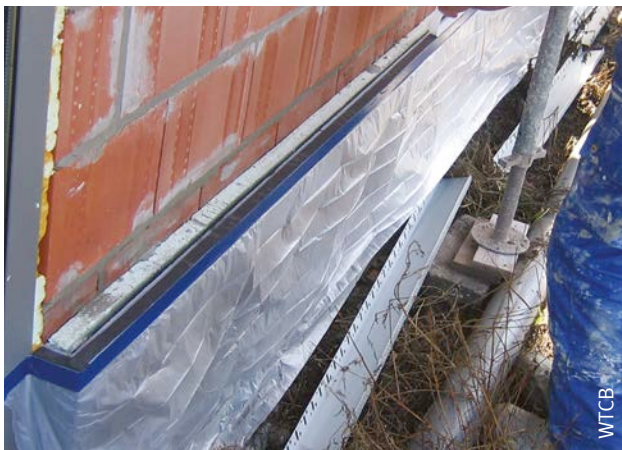
Afb. 95 Plaatsing van een zwelband op de plint.
