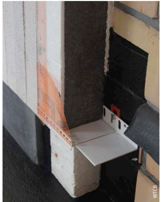
Afb. 46 Plint die verlijmd is op de sokkelisolatie.
