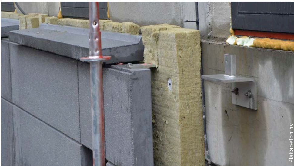
Afb. 84 Voorbeeld van een aansluiting met een spouwmuur.
