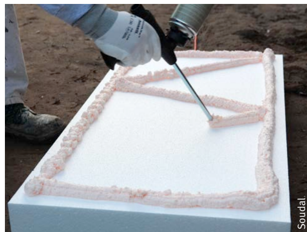
Afb. 114 PU-lijmschuim dat met een pistool wordt aangebracht op een isolatieplaat.
