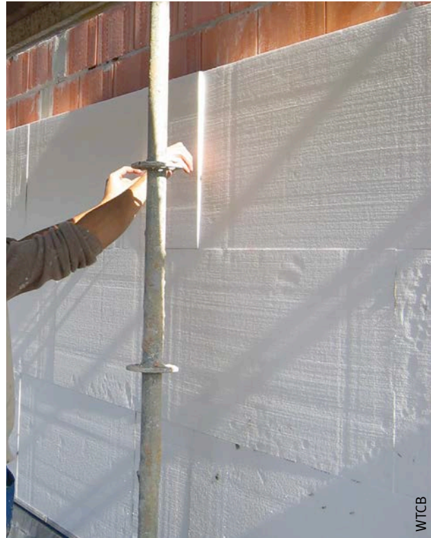
Afb. 101 Plaatsing van isolatieplaten met verspringende verticale voegen.
