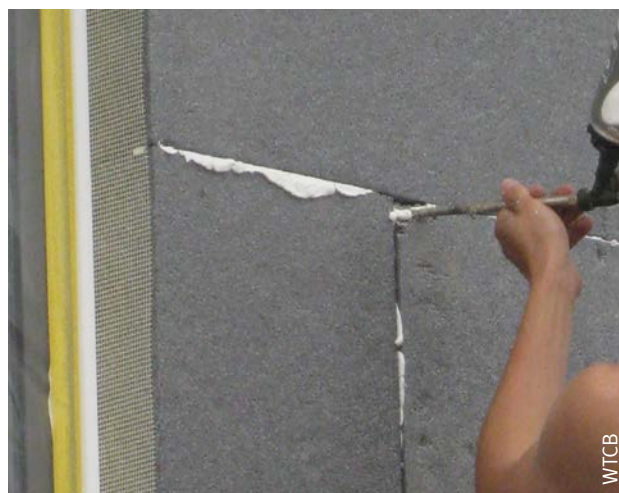
Afb. 121 Opvulling van de voegen tussen de isolatieplaten met een aangepast opzwellbaar PU-schuim.
