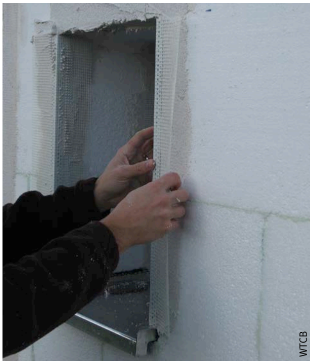
Afb. 124 Plaatsing van een hoekprofiel.
