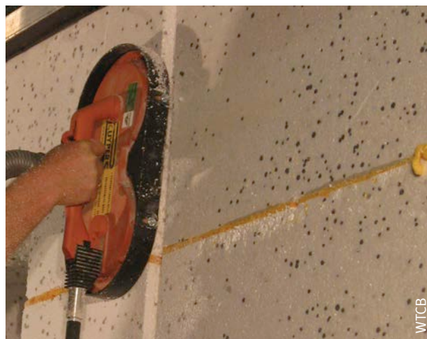
Afb. 122 Afschuren van het oppervlak van de isolatie (platen uit EPS).
