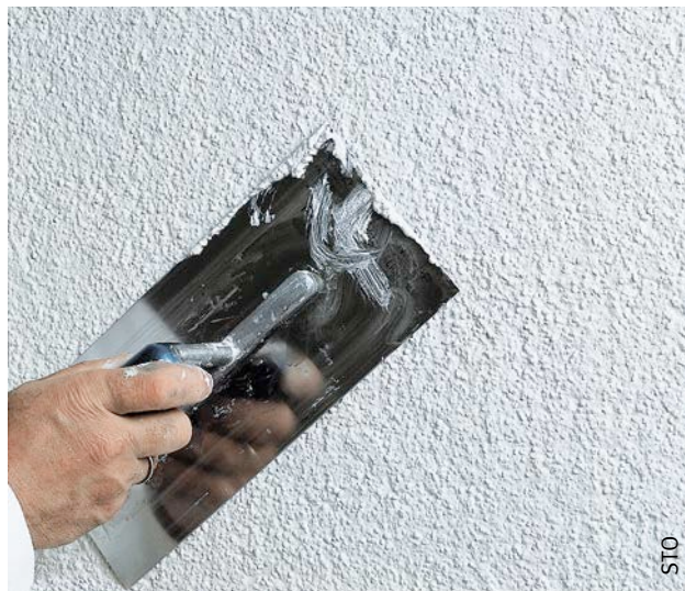
Afb. 136 Gladmaken van een dun afwerkpleister.
