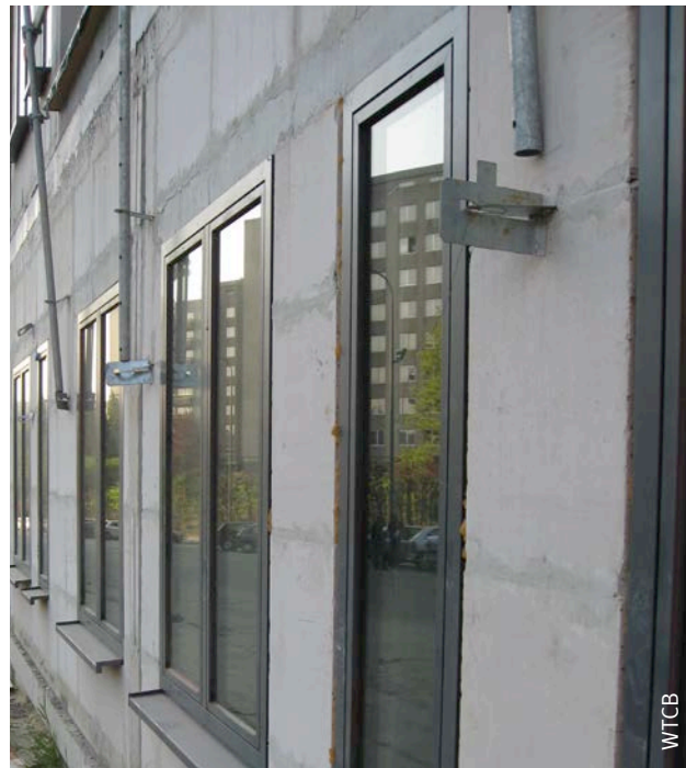
Afb. 54 Plaatsing van het vaste deel van het raamkader gelijkliggend met de buitenzijde van de muur.
