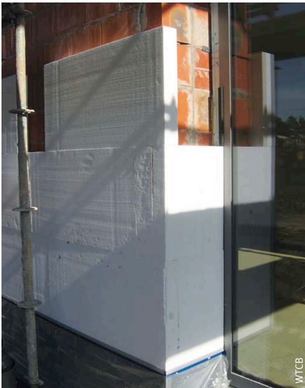
Afb. 102 Vertanding ter hoogte van de dagkant van het raam.
