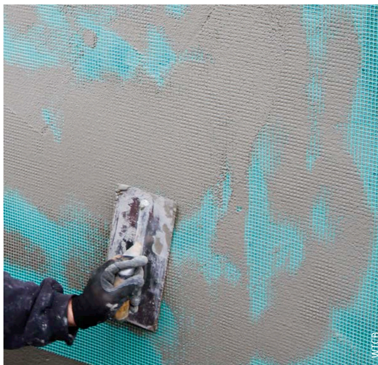
Afb. 3 Het aanbrengen van het gewapende grondpleister van een ETICS.
