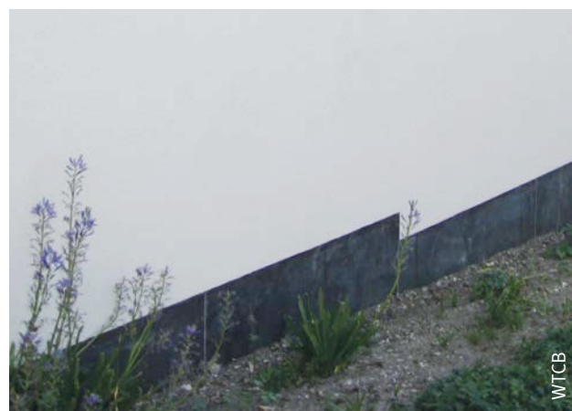
Afb. 98 Trapvormige muurvoet.
