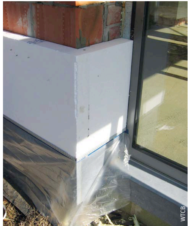
Afb. 112 Plaatsing van de isolatie tegen de zwelband met het oog op de samendrukking ervan.
