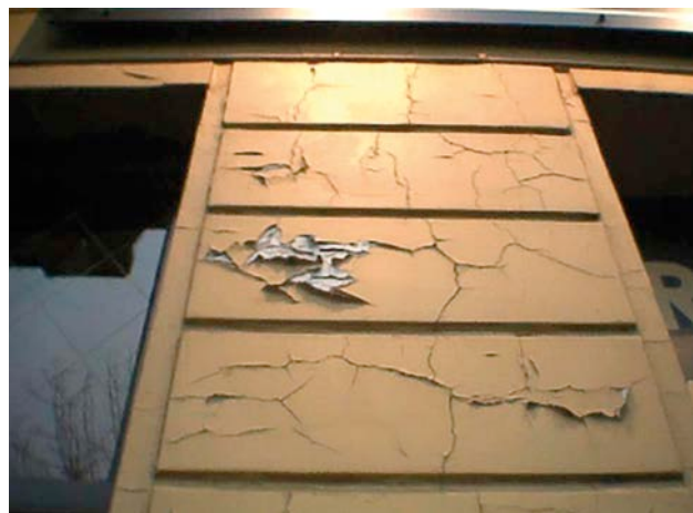
Afb. 10 Veroudering van een verf op basis van alkydhars.
